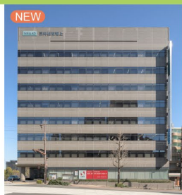
熊本イーストフロントビル
