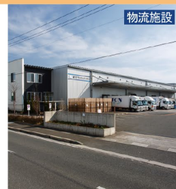
鳥栖ロジスティクスセンター
