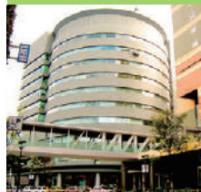
キャナルシティビジネスセンタービル
