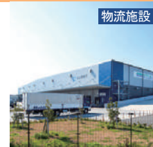
鳥栖ロジスティクスセンター
