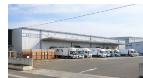
鳥栖ロジスティクスセンター
