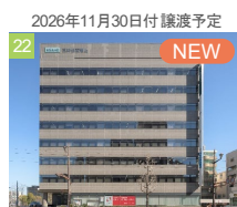
22 熊本イーストフロントビル
